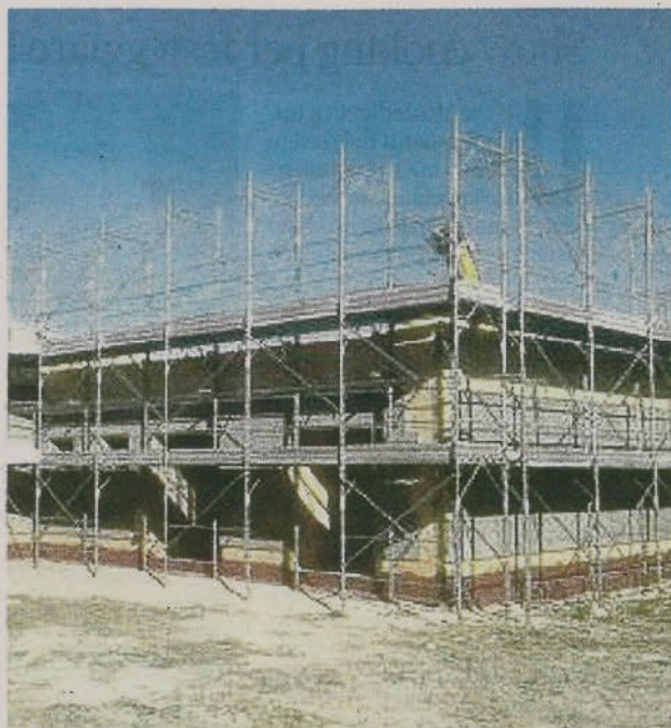
La struttura portante della nuova scuola elementare di Marcelli
