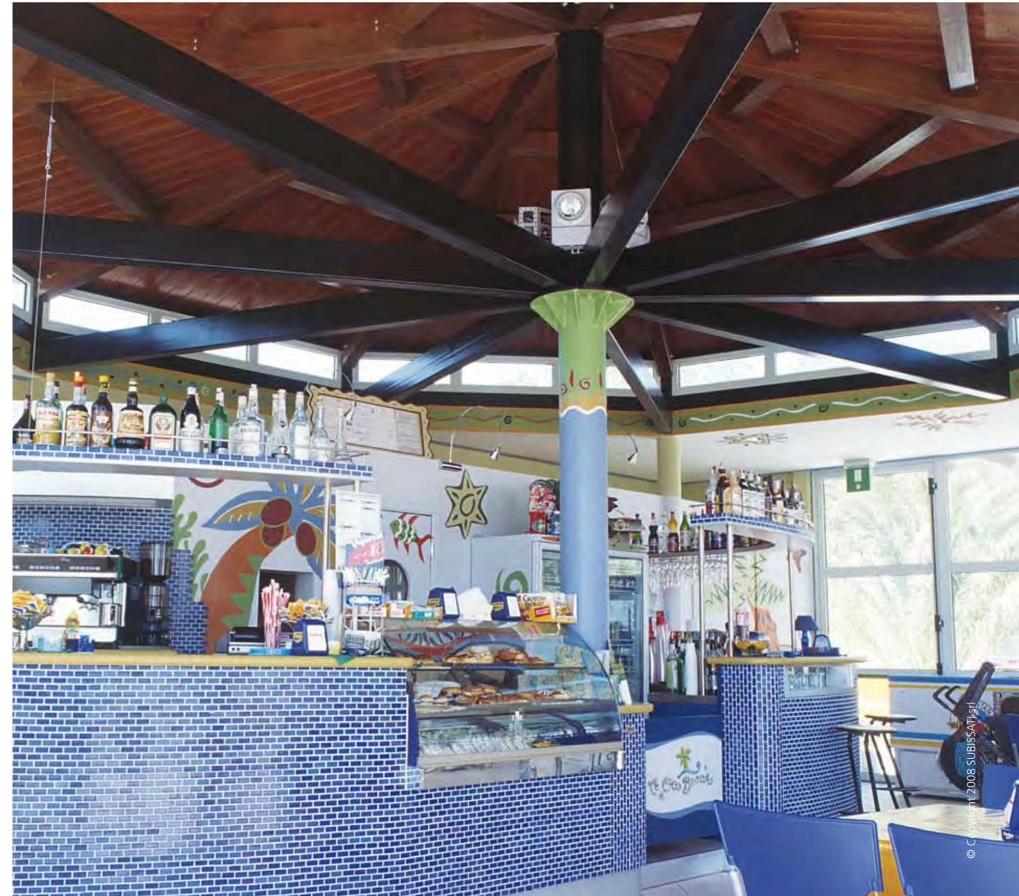
Struttura poligonale irregolare, con pilastro centrale in acciaio e saette in legno
